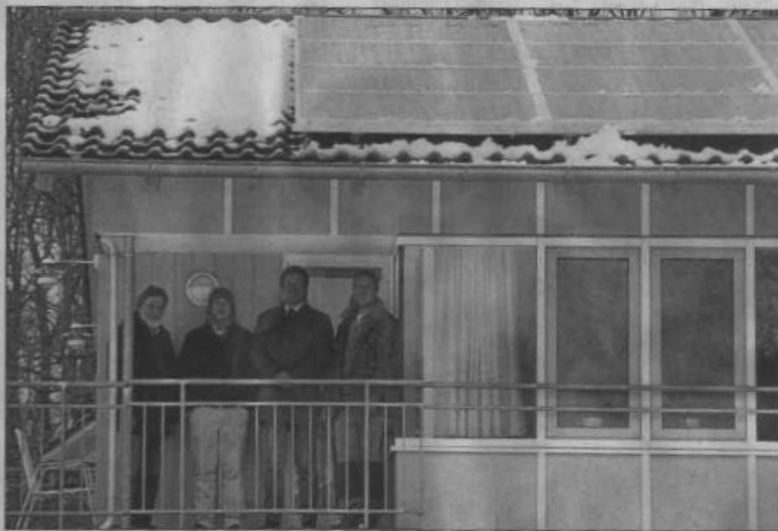
Freuen sich über die Photovoltaikanlage auf dem Dach des Apartmenthauses im SOS-Kinderdorf (von links): Kinderdorfleiter Erich Schöpflin, Benjamin Hofbauer von DHB, Axel Beese von S.A.G. Solarstrom und Dorfmeister Manfred Bauer
